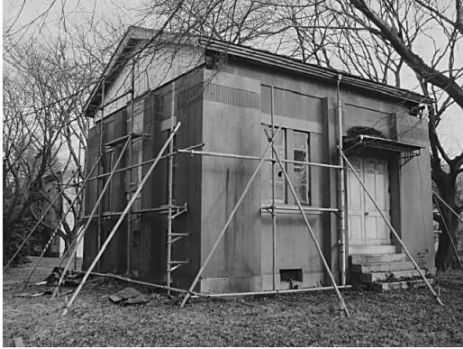
写真3 外観工事中のレプソルド子午儀室.
