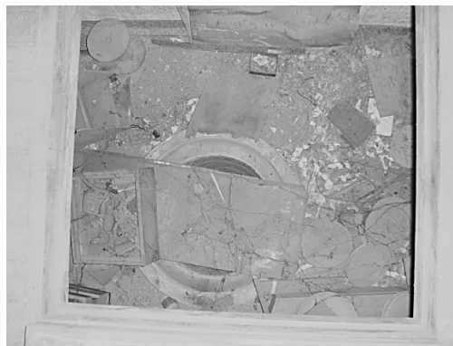
写真10 ハッチの下にある深い穴。
