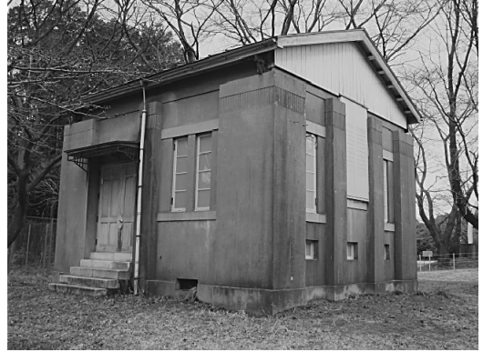
写真4 外観の改装が終わった子午儀室.
