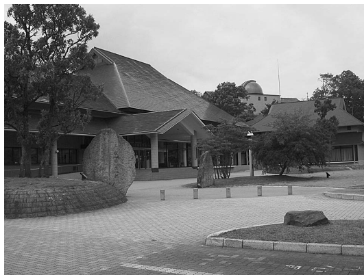
図1 三瓶自然館外観。
