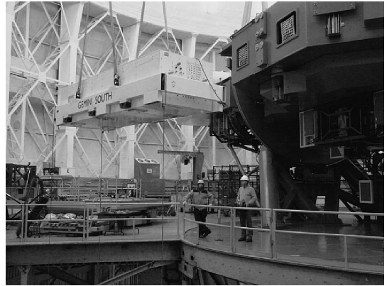
図 4 GeMS レーザーの Gemini 南望遠鏡への取り付けの様子。ロッキードマーチン社によって製作された 50 ワットレーザーが、2010 年 7 月に取り付けられた。
