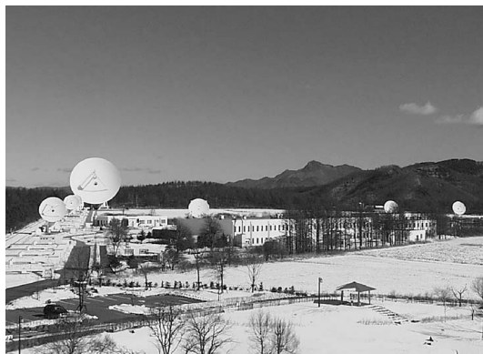
図3 野辺山 RAINBOW 干涉計 (国立天文台提供). 6台の10 m 望遠鏡(野辺山ミリ波干涉計)に、45 m 望遠鏡を結合させた干涉計で、特に波長3 mm 帯(周波数100 GHz 付近)で高い感度を誇る。
